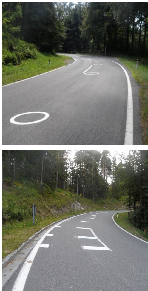
Image 5: special road marking on PTW driving lines © KfV (Kuratorium für Verkehrssicherheit), Austria
