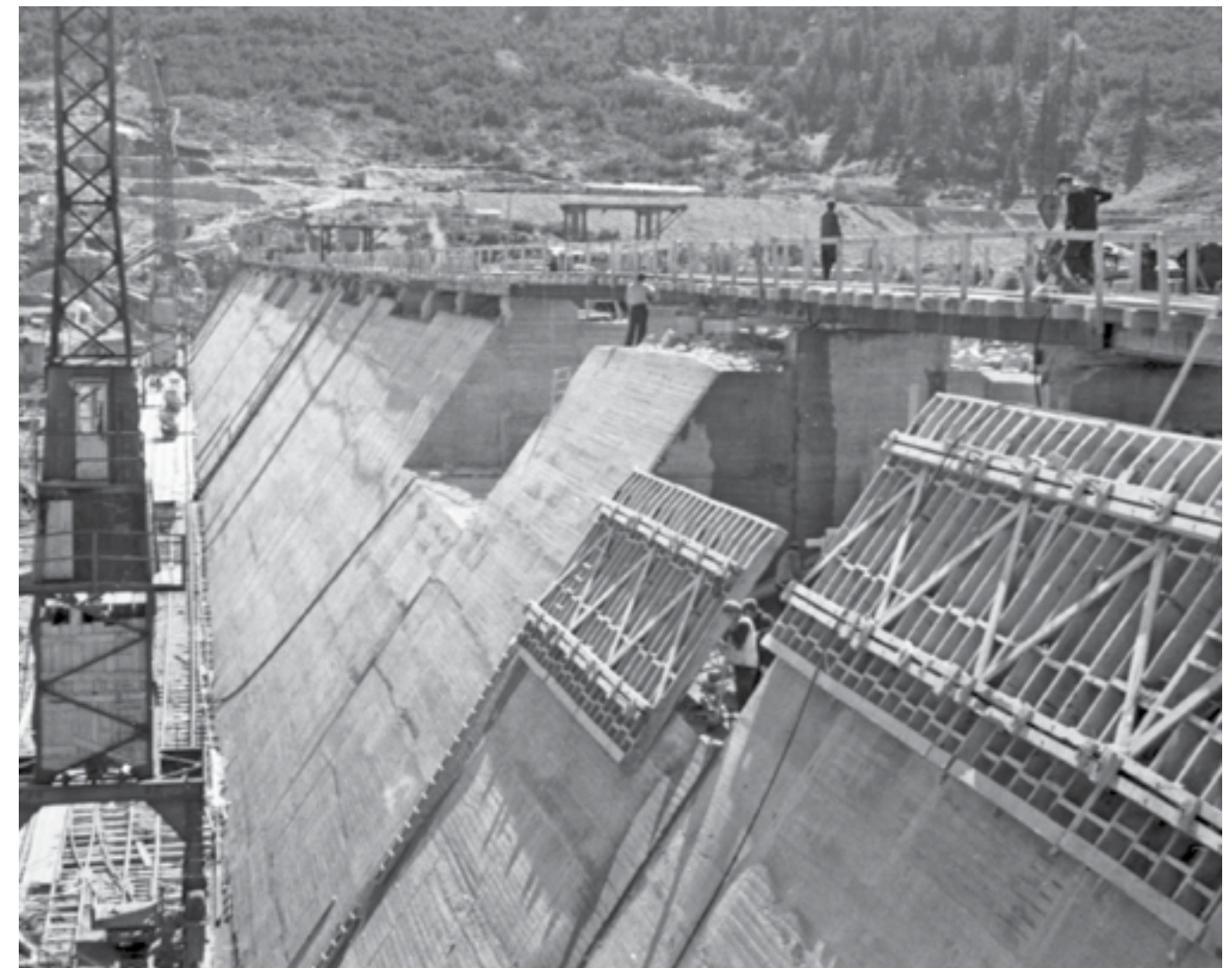
Строежът на язовир „Бели Искър“ през 1943 г. Снимка: БТА архив
