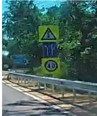
т 16 неправилно монтирани 3 знака на 1 стълб
