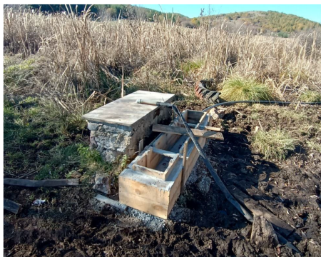
Начало на ремонта, октомври 2024г.
