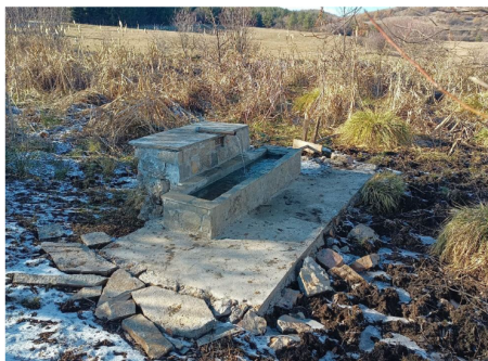
Завършен ремонт, ноември 2024г.
