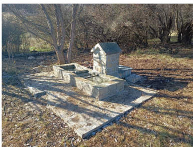
Завършен ремонт, ноември 2024г.
