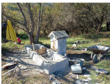
Начало на ремонта, октомври 2024г.
